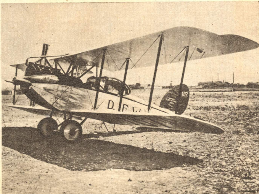
Dieses Junkers-Flugzeug gehört zu den Veteranen der deutschen Verkehrsluftfahrt und bietet ein gutes Schulbeispiel für die Übertragung der vom Kriegsflugzeugbau übernommenen Bauformen auf den Bau von Verkehrsflugzeugen
